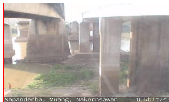
สถานีสะพานเดชาดิวงค์ ต.ปากน้ำโพธิ์ อ.เมือง จ.นครสวรรค์ (ลุ่มน้ำเจ้าพระยา)
